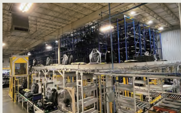
立体自動倉庫
